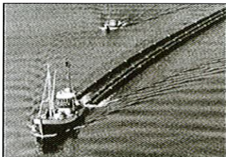
Spillvattenledning, Mörrums bruk, Sverige, 1970, storlek 1000 mm, längd 2000 m.
