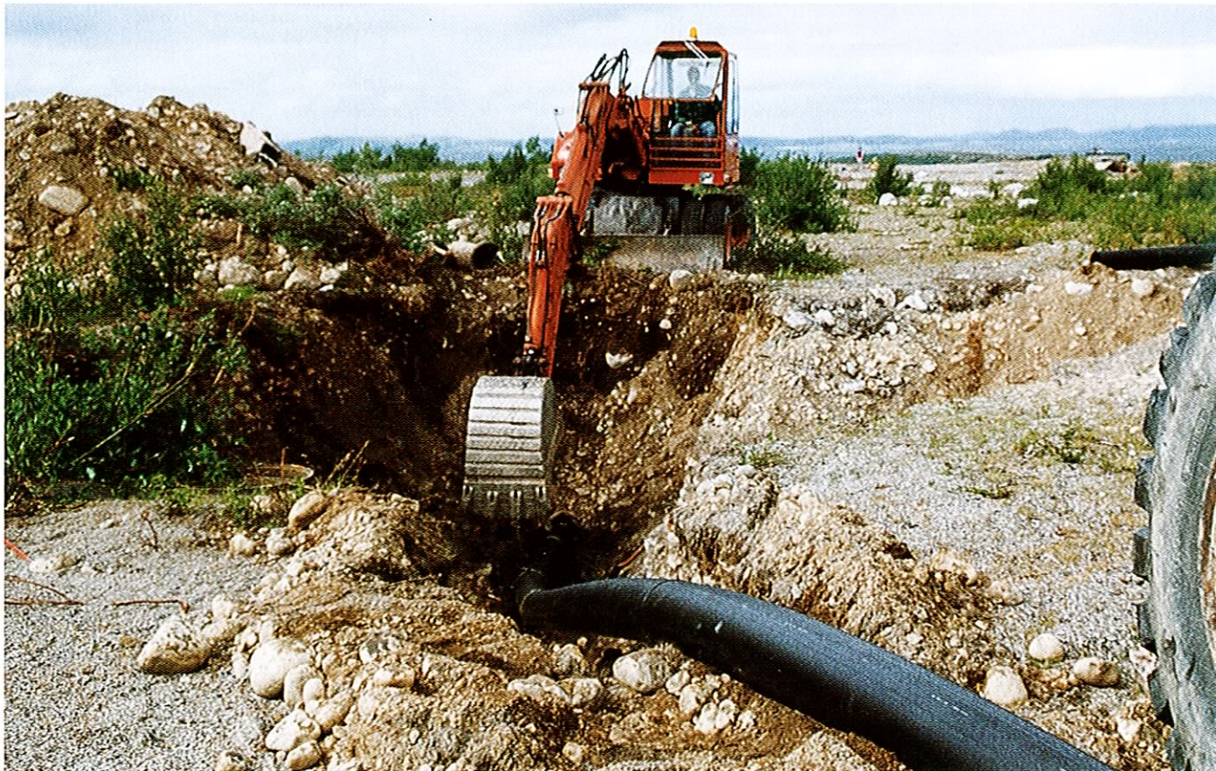
Bild 2.4.A Relining med PE-rör
