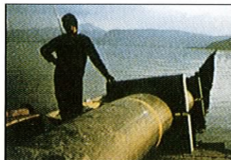
Avloppsledning, tillverkad på plats med en mobil enhet, vid Attersee, Österrike, 1975-76, storlek 630 mm, längd 5000 m.
