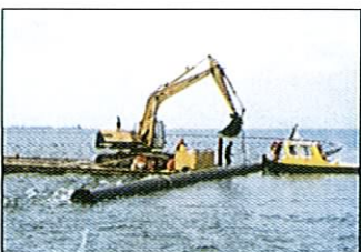
Utloppsledning, Wismar, Tyskland, 1996, storlek 800 mm, längd 930 m.
