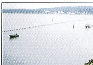
Rörledning för avloppsvatten, Hundsfoss pappersbruk, Norge, 1994, storlek 710 mm, längd 17300 m.
