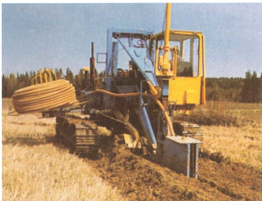
Installation med täckdiktningssmaskin
