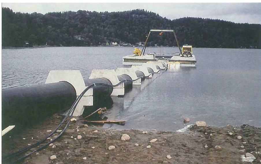
Fig. 59: Viktning och utläggning av sjöledning
